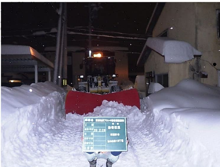
生活道路(困難路線)の除雪状況
