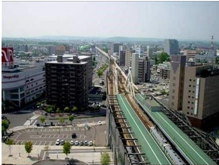
平成8年 駅南北の利便性が増した鉄道高架
